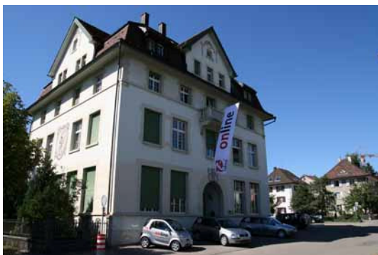
Bild Nr. 04-01 OC_Haus.jpg. Heimat für rund 50 Mitarbeiter. Firmenzentrale der Online Group in Wil.
